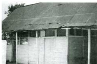
قسم من المنزل القديم للكلونيل في أراكاتاكا قبل أي ترميم أُضيف عليه.
