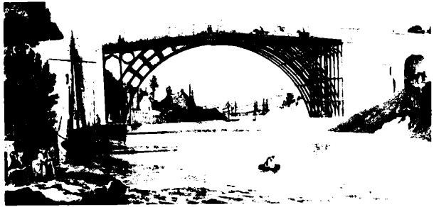
٢٦٢ جسر كولبروكديل في شروبشر. ١٧٧٧ - ١٧٨١. تصميم برنارد. يعتبر أول جسر انشء من مادة الحديد الصلب.
