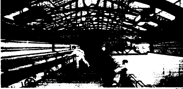
٢٥١ عظمت لعمل يظهر استخدام جسور من مادة الحديد الصلب الذي يمكن من تصميم باع واسع لتسهيل عملية الأنتاج
