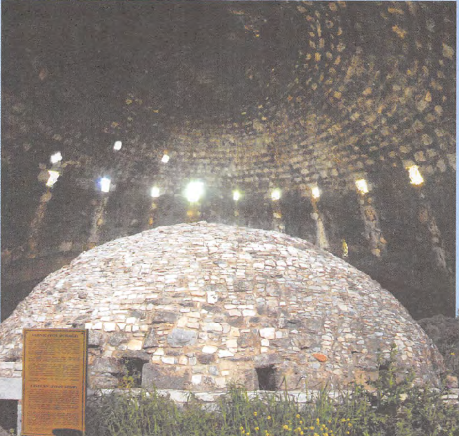
مشيدين خارجي وداخلي لخزانات المياه التي انشأها القانوني من أجل خطة رودس
